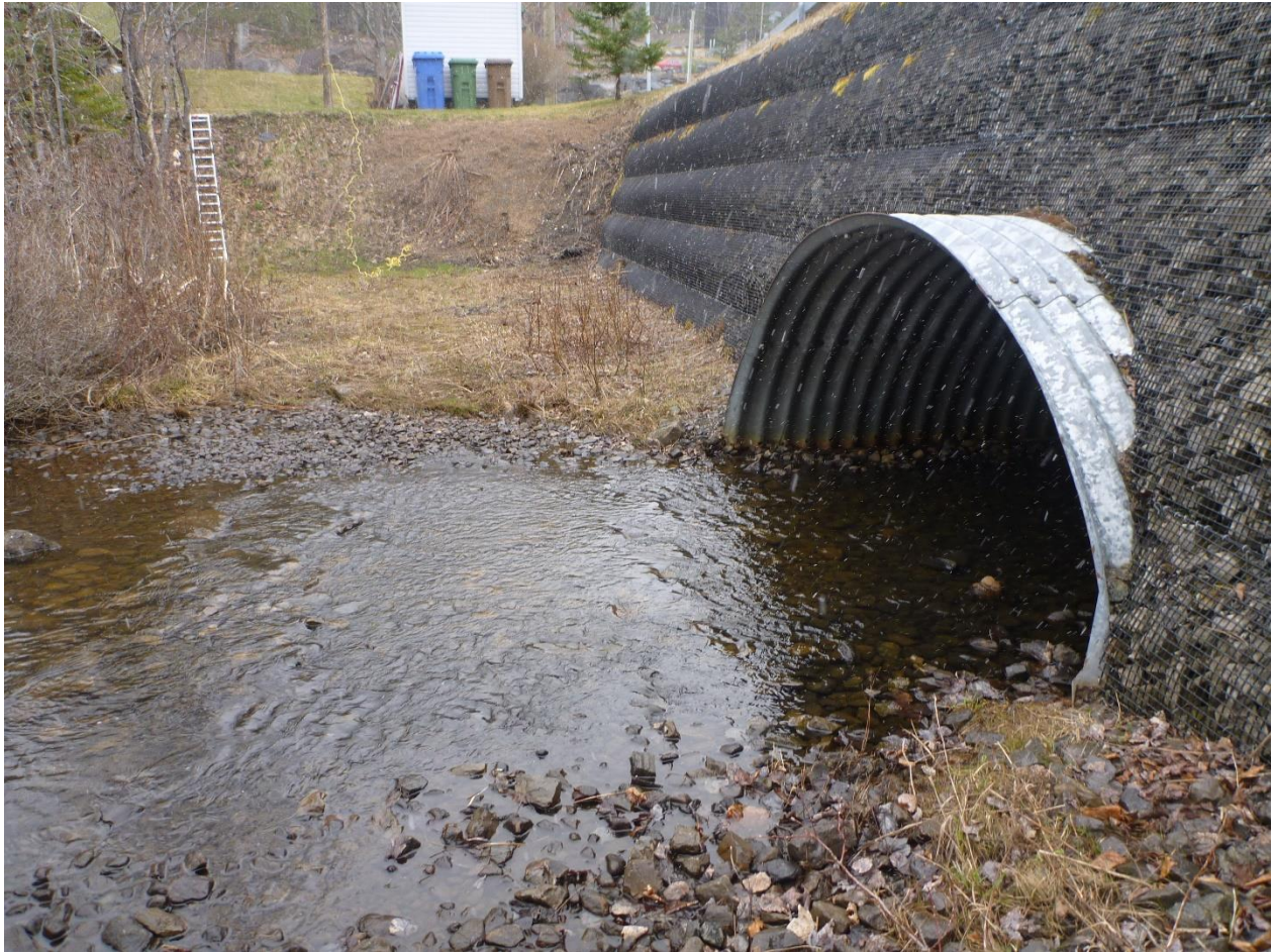
Figure 24 Enrochement au niveau du pont traversant l’effluent du lac Écho (sur le Chemin des Brumes)
