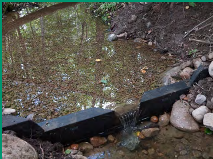
Seuil et frayère dans le ruisseau de la 1 re Avenue
