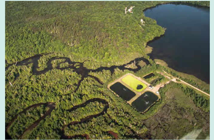
Station d'épuration des eaux usées de Lac-Delage (crédit : William Verge)
