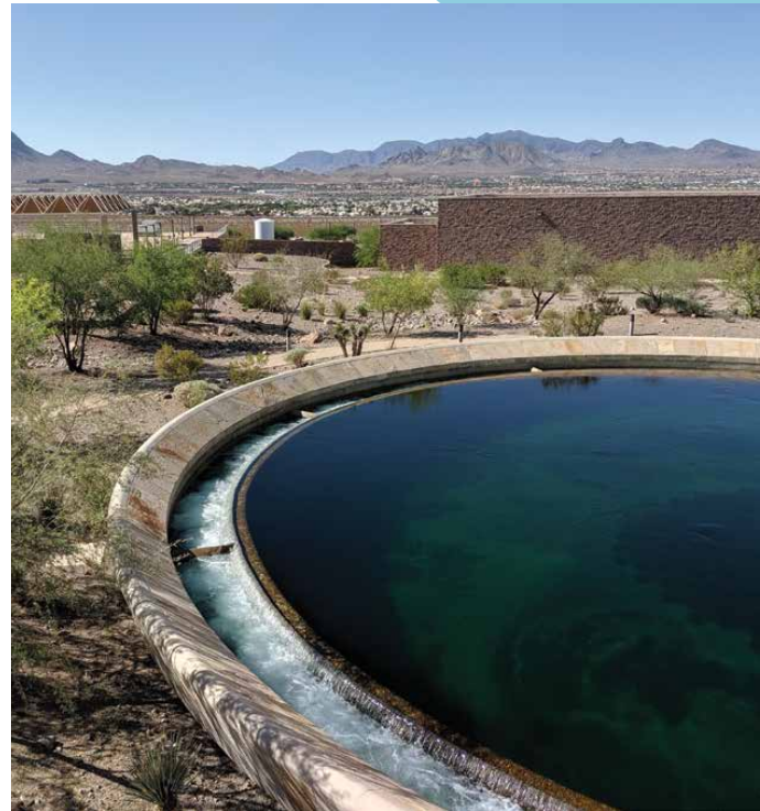
Usine d'eau potable
