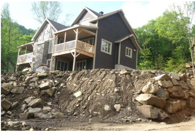
Figure 8. Photos du nouveau développement résidentiel lors de sa construction démontrant le potentiel érosif du site. À gauche: Lot typique de ce développement en montagne ayant nécessité beaucoup de remblai. Le sol reste à nu longtemps après la finition de la maison et le matériel de remblai s'érode. À droite: Photo démontrant le relief très accidenté des rues de ce développement. Des signes d'érosion sont visibles dans la rue non pavée.
