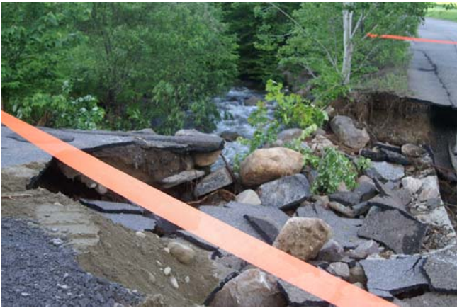
Figure 6. Partie de la route arrachée par le débordement du ruisseau de la station touristique (arrière-plan) en juin 2008.
