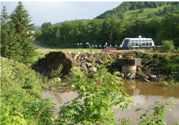
Figure 7. Digue du bassin de rétention ayant cédé en juin 2008. L'écoulement se fait vers la rivière Hibou. À gauche: Vue de l'intérieur du bassin, vers la rivière Hibou. À droite: Vue de l'extérieur du bassin, en regardant vers l'amont.
