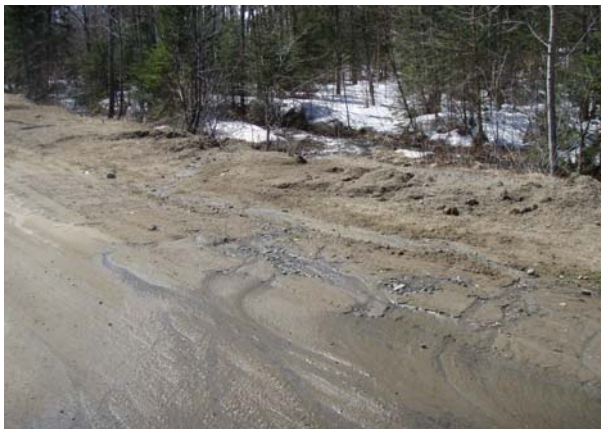
Figure 4. Signes d'érosion dans le stationnement de sable de la station touristique de Stoneham. L'écoulement se fait vers la rivière Hibou.
