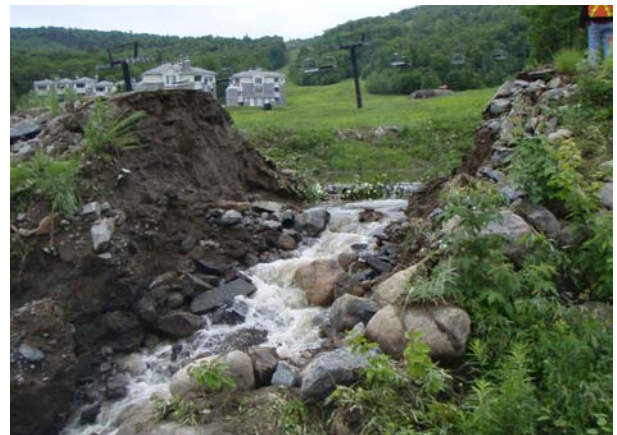
Figure 7. Digue du bassin de rétention ayant cédé en juin 2008. L'écoulement se fait vers la rivière Hibou. À gauche: Vue de l'intérieur du bassin, vers la rivière Hibou. À droite: Vue de l'extérieur du bassin, en regardant vers l'amont.
