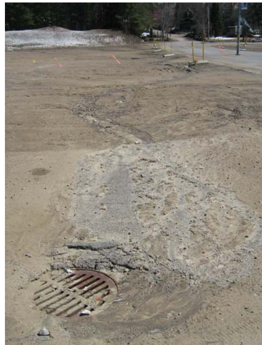
Figure 4. Signes d'érosion dans le stationnement de sable de la station touristique de Stoneham. L'écoulement se fait vers la rivière Hibou.
