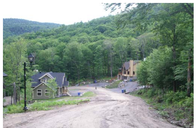
Figure 8. Photos du nouveau développement résidentiel lors de sa construction démontrant le potentiel érosif du site. À gauche: Lot typique de ce développement en montagne ayant nécessité beaucoup de remblai. Le sol reste à nu longtemps après la finition de la maison et le matériel de remblai s'érode. À droite: Photo démontrant le relief très accidenté des rues de ce développement. Des signes d'érosion sont visibles dans la rue non pavée.
