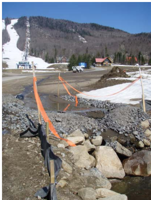
Figure 5. Méthodes de contrôle de l'érosion mises en place en 2008 dans le stationnement de la station touristique. À gauche: zone récemment ensemencée. À droite: bassin temporaire permettant de retenir une partie des sédiments contenus dans l'eau de ruissellement.
